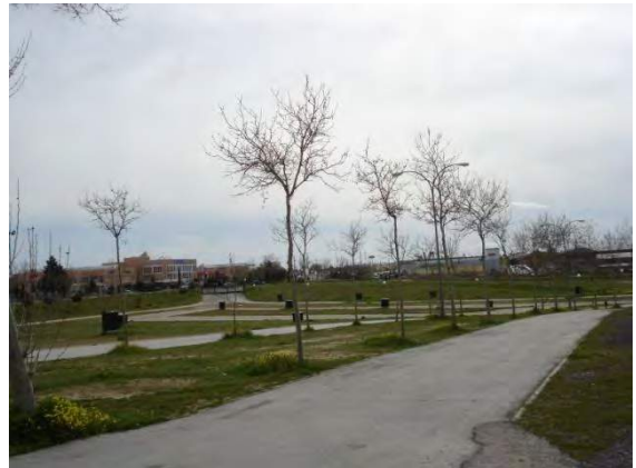
4. Armarios eléctricos situados en la mitas este del recinto
