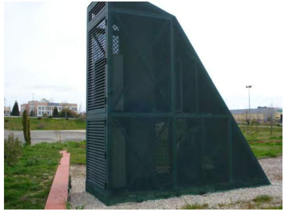
14. Vista lateral de chimenea de ventilación y cubierta de la estación de transferencia de residuos
