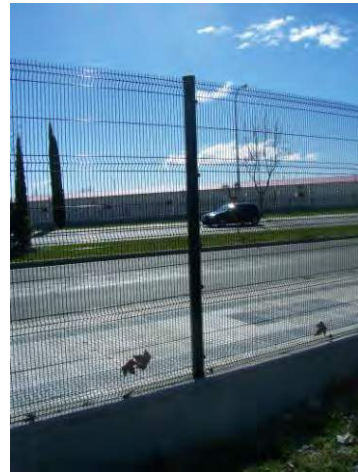
16. Detalle del vallado perimetral existente
