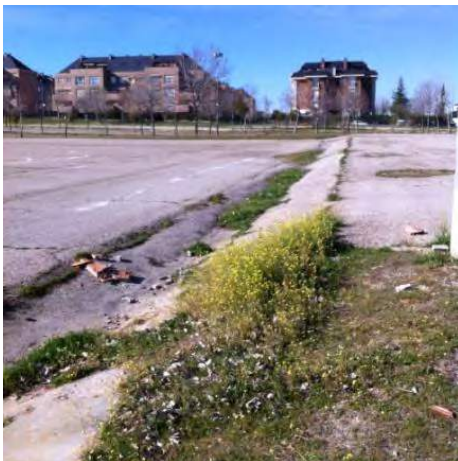
23. Cuneta existente en la explanada de conciertos
