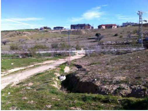
25. Camino de acceso al cauce que limite el recinto ferial al este.
