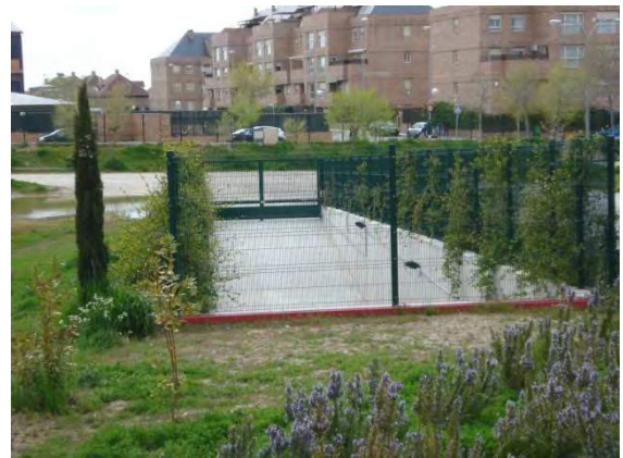
12. Rampa de acceso a estación de transferencia
