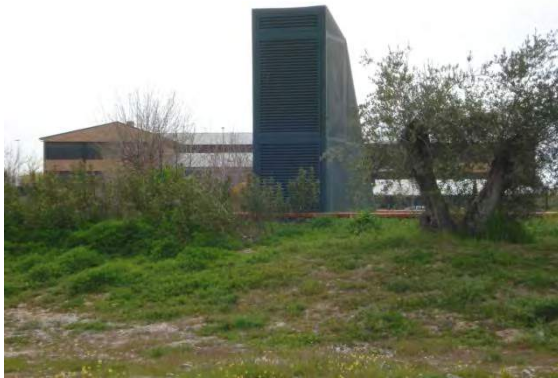
15. Vista trasera de chimenea de ventilación y cubierta de la estación de transferencia de residuos
